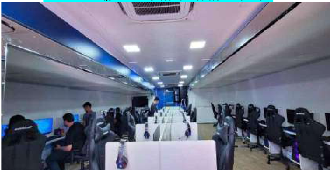
PARTE INTERNA- EQUIPE FAZENDO AJUSTES- PROCESSO DE MONTAGEM
